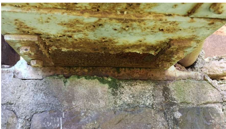
Apoyo Tramo 31 a-
