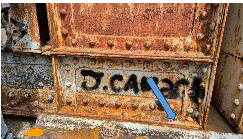
Vista exterior de apoyos
