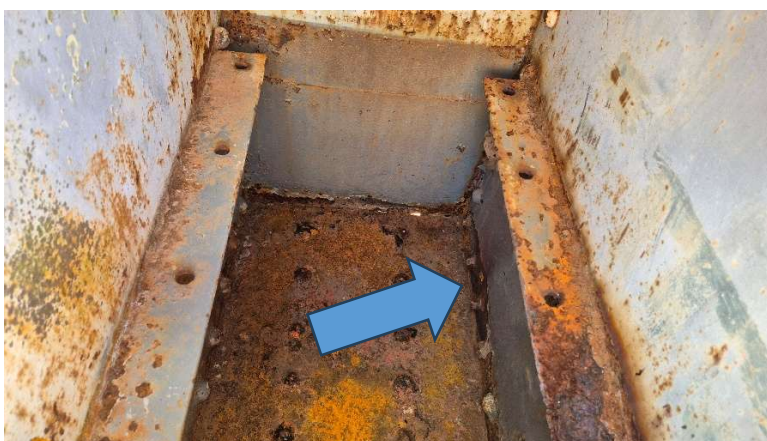
Vista interior de apoyos
