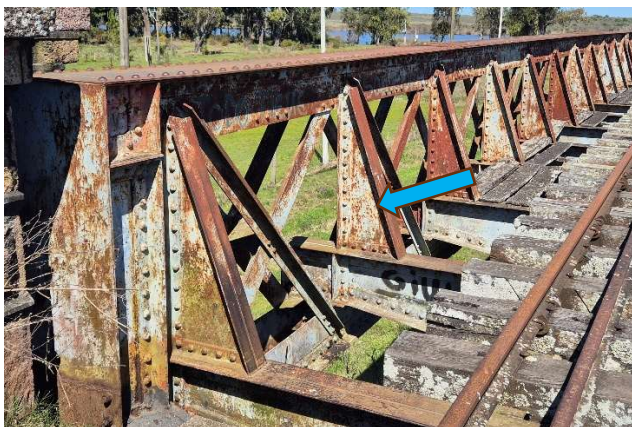
Vista de escuadras, Tramo 31
